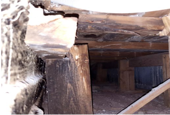
Kuva 1. Ilman todettiin siirtyvän putkikanaaleista oleskelutiloihin.
