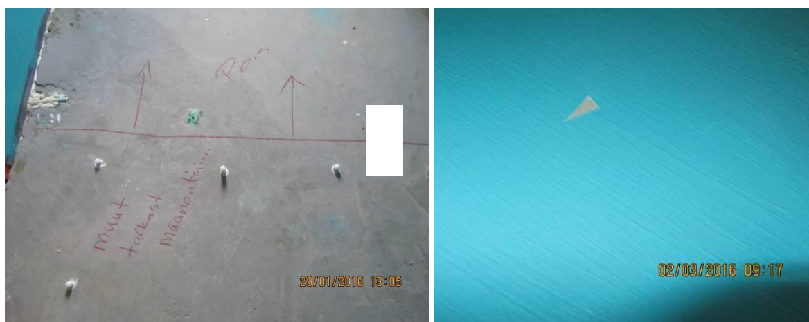
Kuvat 7. ja 8. Märkätilojen laadunvarmistus, kuvissa kosteusmittaus sekä vedeneristeen kuivakalvopaksuuden mittaaminen
