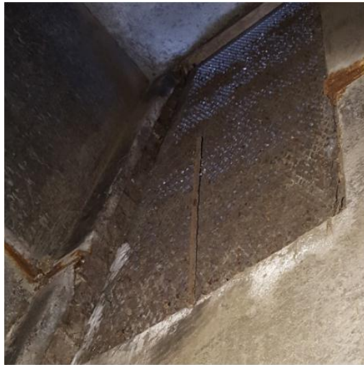
Kuva 4. Lumisäleikkö on tukossa.
