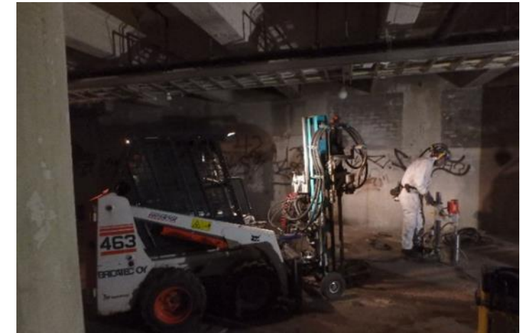
Kuva 23. Rakennuksen alapuolisen maaperän tutkiminen on haastavaa.
