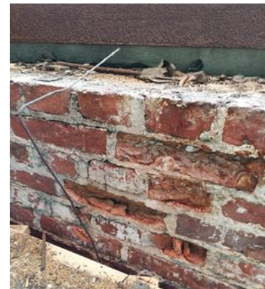
Kuva 3. Muurin yläosassa ovat erityisesti matalapolttoiset tiilet rapautuneet pahoin Kuva 4. Nainen sotkee laastia Sokoksen työmaalla. Kuvaaja Pekka Kyytinen, 1945–1949. Museovirasto, Kansatieteen kuvakokoelma, Pekka Kyytisen kokoelma (Finna 2021).
