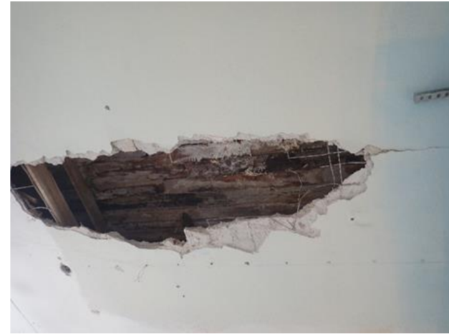
Kuva 15. Yleensä mikrobikasvu alkaa ensin herkimmin vaurioituvassa materiaalissa. Kuva 16. Myös tiilirakenne voi mikrobivaurioitua, jos olosuhteet ovat suotuisat ja aikaa on
