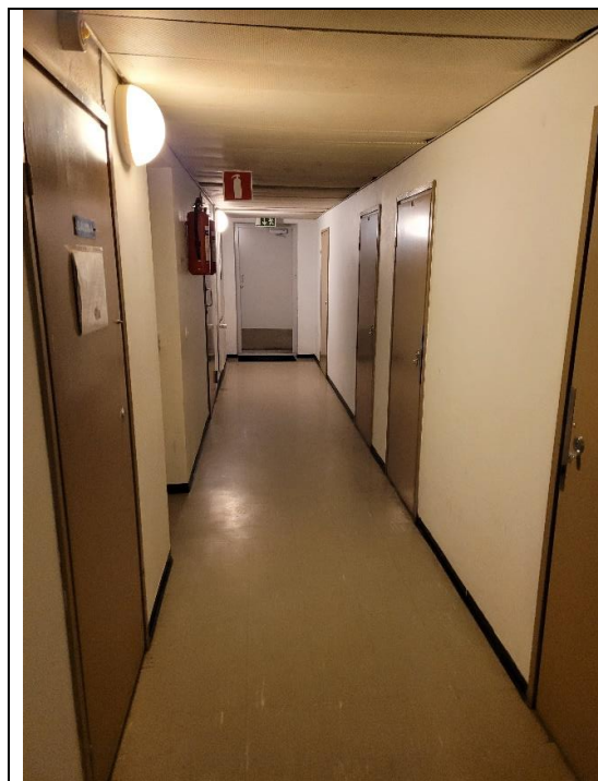
Kellarikäytävän seinämaalinäytteessä esiintyy PCB-yhdisteitä 145,13 mg/kg .
