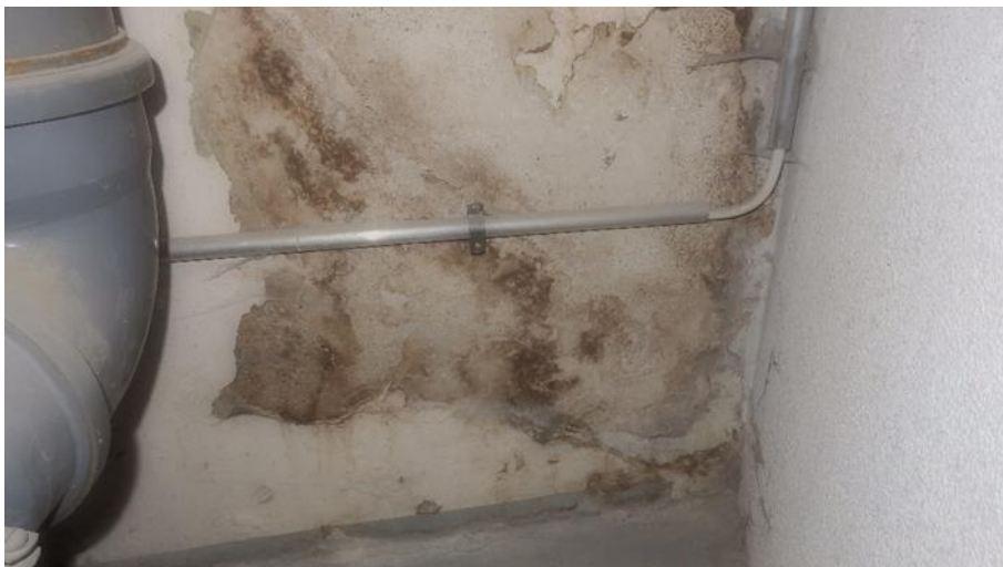
Kuva 4. Parkkihallin ja ”kellaritilojen” välisen yhdyskäytävän maanvastainen seinä, joka rakennettu 1960.
