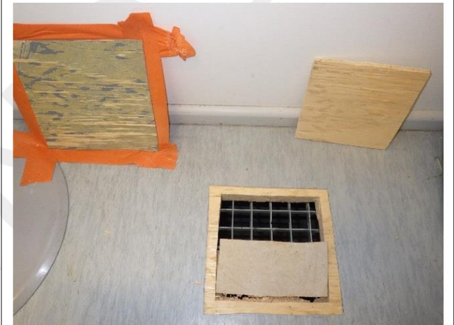
Kuva 143. Pukuhuoneen lattian avausta.
