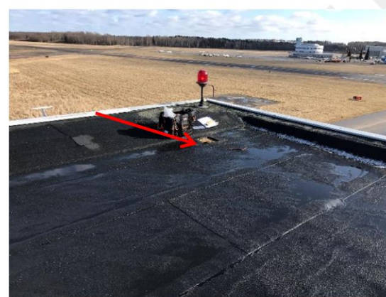
Kuva 169. Yläpohjan rakenneavaus lentokonehallin yläpuolella.
