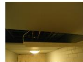
A013 alakaton akustolevyjen leikatut osat pinnoitettu saunasuojalla Kuva 4.
