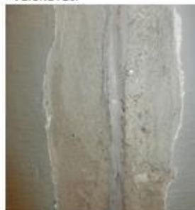
A013 seinän liikuntasauga hiottu ja täytetty elastisella kitillä Kuva 1.
