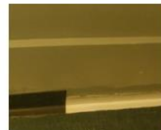
A013 seinä/alakattoliittymä tiivistettynä Kuva 3.
