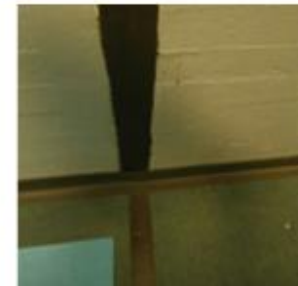
A013 liikuntasauga tiivistettynä TDET 2.1 Kuva 2.
