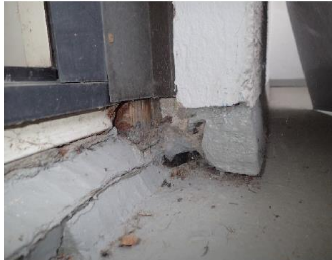
Kuva 59. Kuva parvekelaatan ja ulkoseinän liitoksesta
