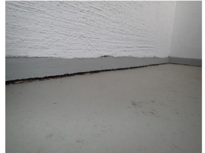
Kuva 60. Kuva parvekelaatan ja ulkoseinän liitoksesta
