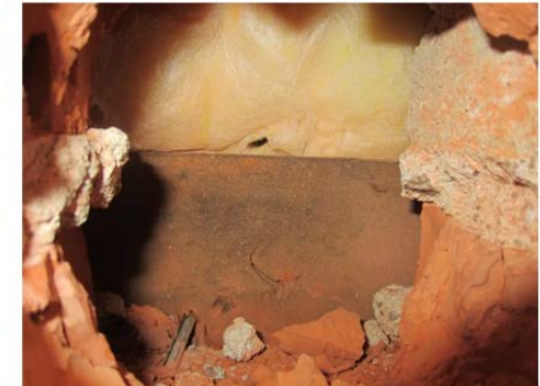
Kuva 25. RA3. Ulkoseinän mineraalivilla kirkasta.
