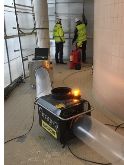
Suojauksien tiiveyden varmistaminen ja hallittu alipaineistus
