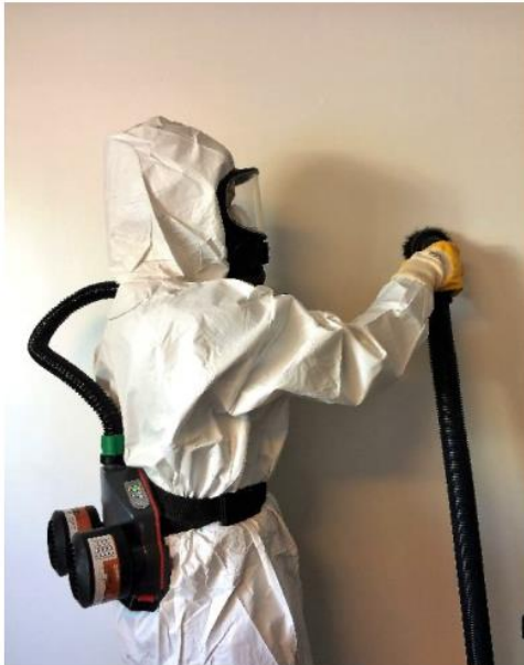
Kuva 1. Homepölypuhdistusta suorittavan henkilöstön oma suojaus Puhallinmoottorilla varustettu kokokasvonsuojain, jonka suojauskerroin on vähintään 40, esim. TH3A2P, tämä suodattaa homeen hajun ja homepölyn. Kemikaalien kestävät viiltosuojakäsineet. Hupullinen kertakäyttöhaalari luokka 5-6. Turvakengät, kengänsuojukset
